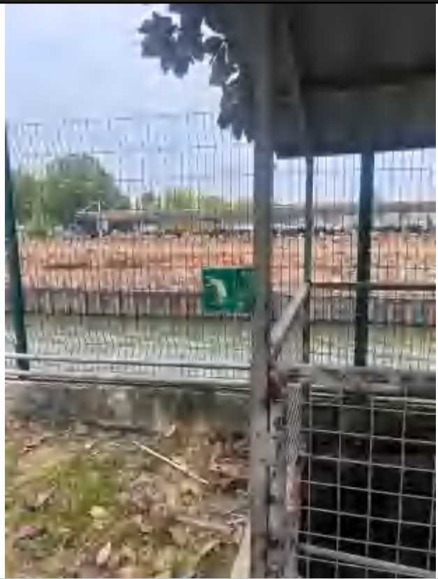
雨水排放口 1 标识牌
