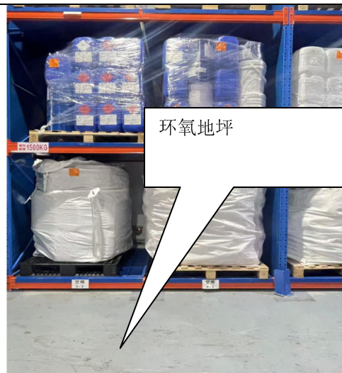
危废仓库防腐防渗
